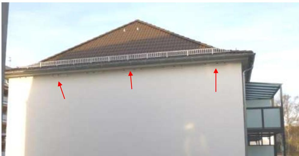
Hier konnten wir sechs Schwegler-Kästen Nr.17/3-fach in die Dämmung einsetzen, mit insgesamt 18 Mauersegler-Nist-Plätzen.
