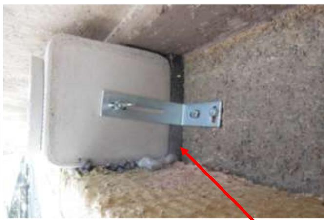
Die Handwerker setzten die Kästen in gleichmäßigen Abständen direkt unter der überstehenden Beton-Traufe. Hinter jedem Kasten sitzt eine hochwirksame Dämmplatte um eine Kältebrücke zu vermeiden. Die Kästen wurden noch eingeschäumt.
