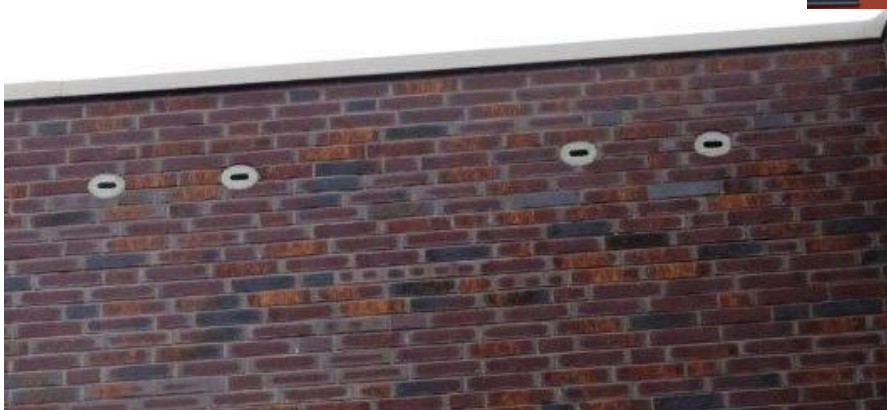
An einem Neubau in Niederrad wurde der Schwegler-Kasten Nr.17C-2fach in die Klinkerwand eingesetzt.
