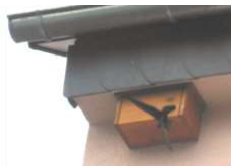
90°, ohne Neigung, unter dem Traufkasten befestigt.
