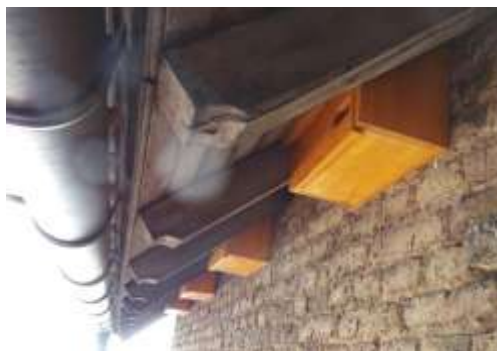
60° Kästen, linksbündig am Dachbalken befestigt.
