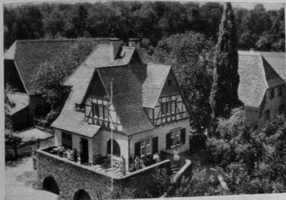
Das von dem Kühkopf-Kuratorium gepachtete staatliche Forsthaus mit Gastwirtschaft und Nebengebäuden auf dem Kühkopf. Aufnahme: Walter Wissenbach.
