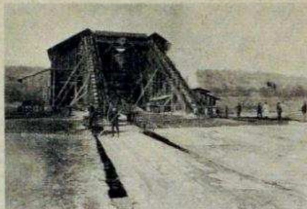
Eislagerhäuser mit Eiselevatoren im Betrieb
