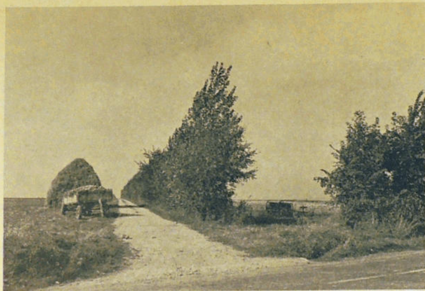
Abb. 2: Versuchsanlage C — Feldteil/Landstraßenteil
