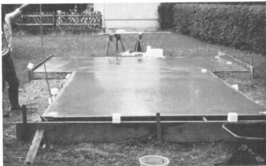
Abb. 4: Erster Bauabschnitt war die über 80 cm tieferreichende Gründung des Bienenhauses als Betonfundament.
