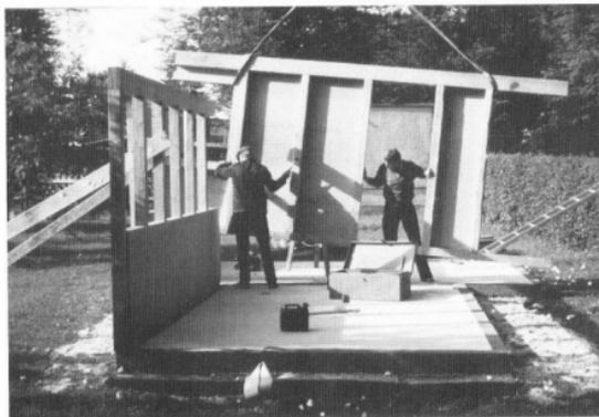
Abb. 5: Die als Fertigteile bereits zuvor erbauten Wandteile ermöglichten ein zügiges Errichten des Bienenhauses.
