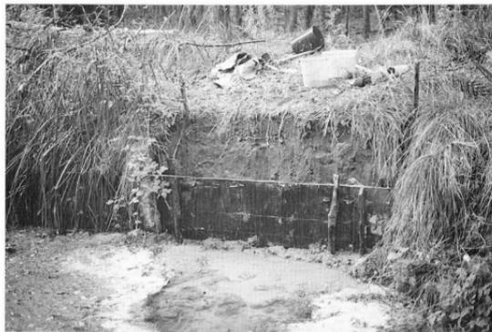
Abb.3: Bau der künstlichen Steilwand.(Abgestochene Rückwand, Verschalung für Betonfundament)
